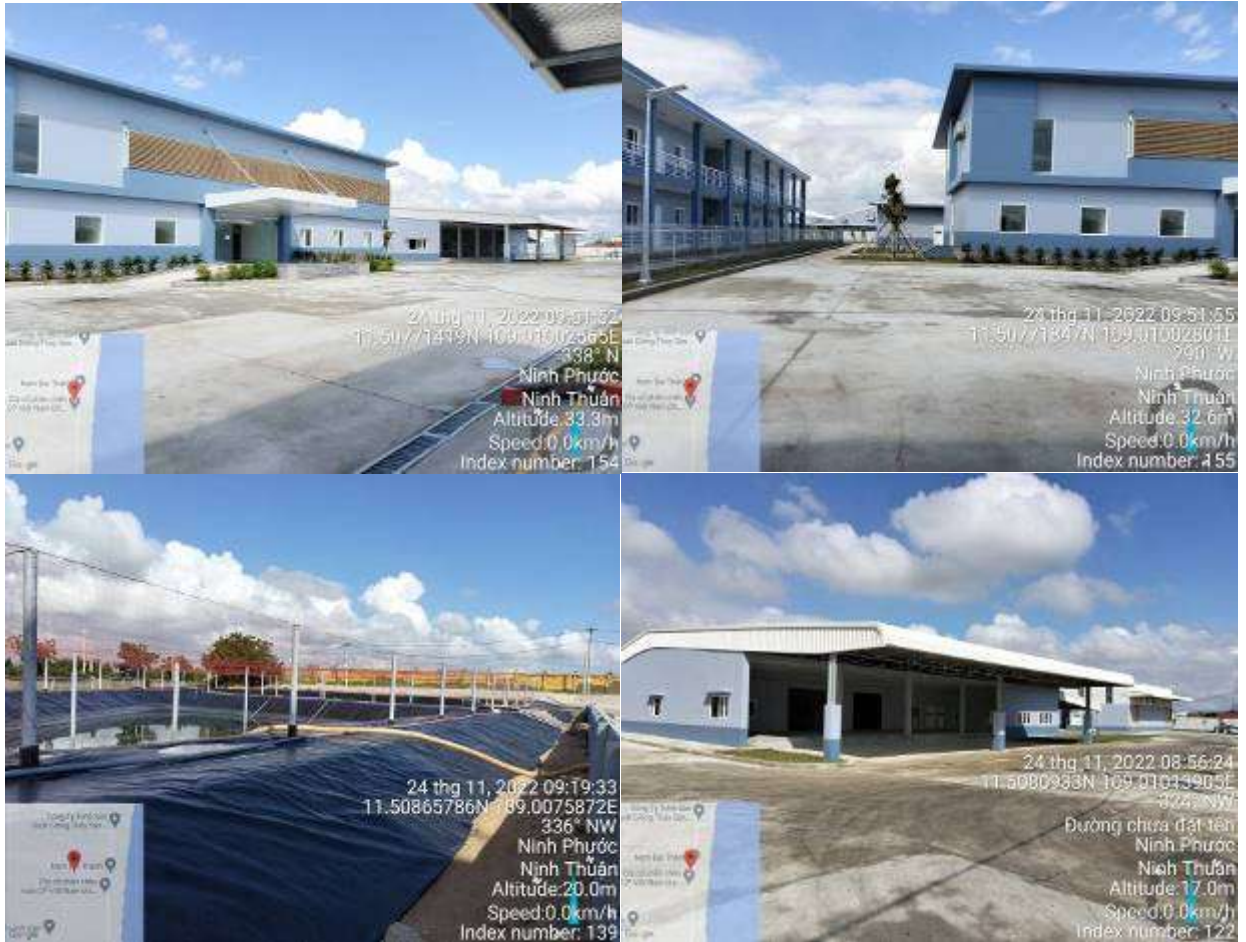
Hình 1.3: Hiện trạng khu vực dự án
