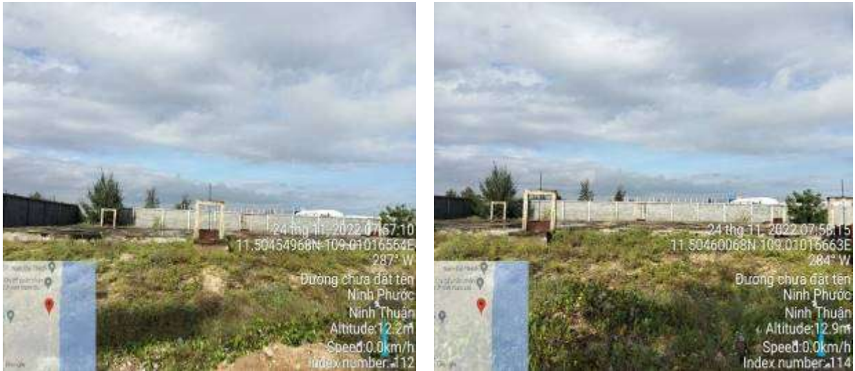
Hình 3.1: Hình ảnh bể chứa nước thải khu 4
